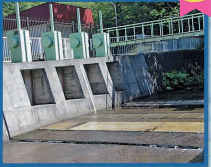
宮町浄水場では札幌市内で唯一、川の水をせき止めず川底から水を取る川底取水を行っています。
