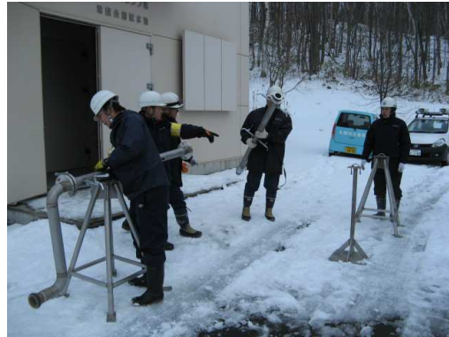
応急給水施設の組立
